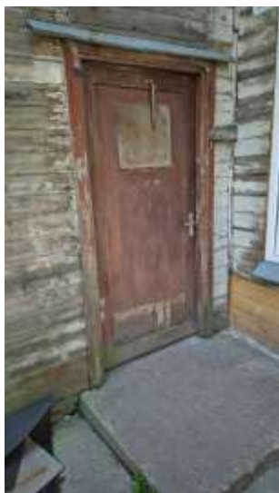
Kāpņu telpas ārdurvis
